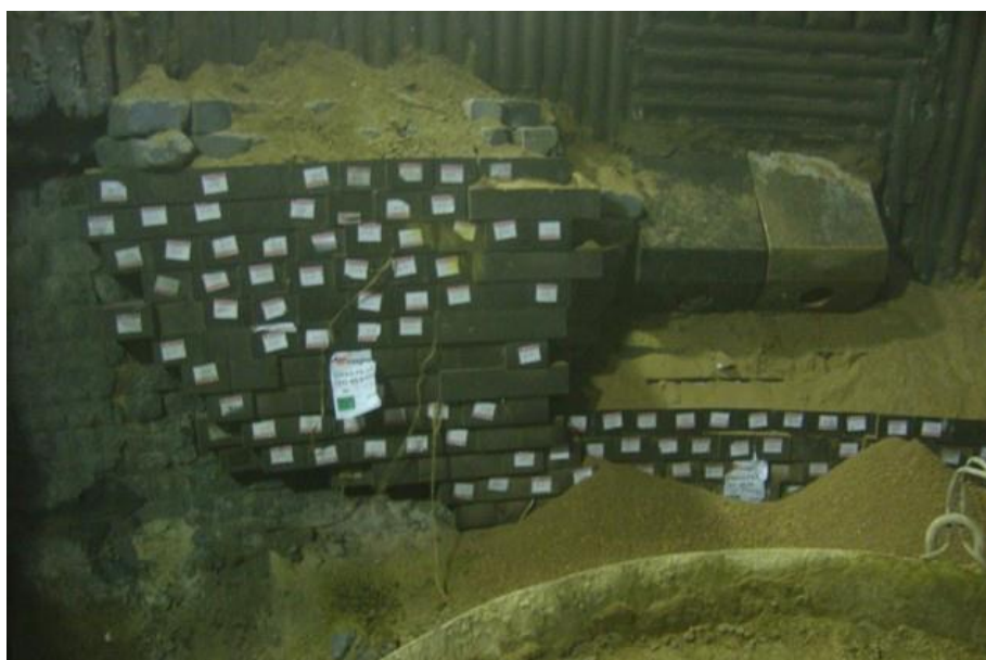
FIGURA 2: Exemplo aplicação refratários forno elétrico a arco
