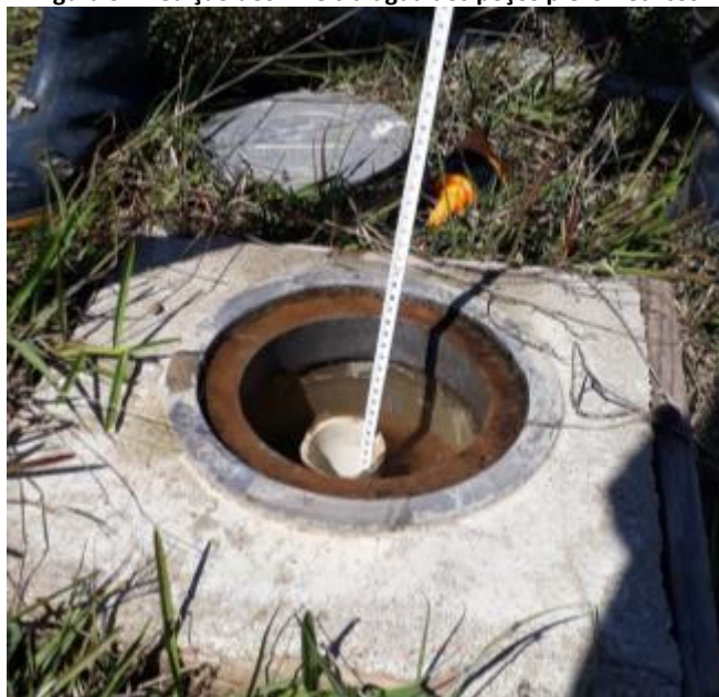
Figura 3: Medição dos níveis d'água dos poços piezométricos
