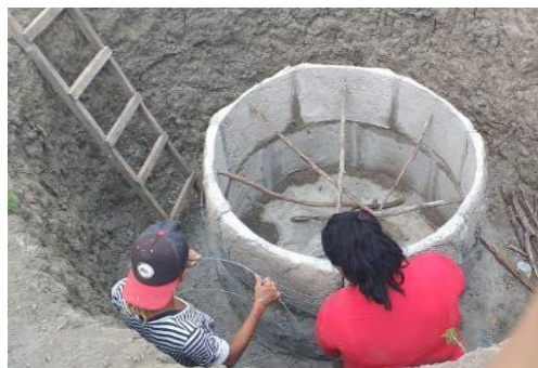
Figura 5. Construção do filtro do reuso pelas mulheres, no assentamento Hipólito, em Mossoró (RN), 2020.
