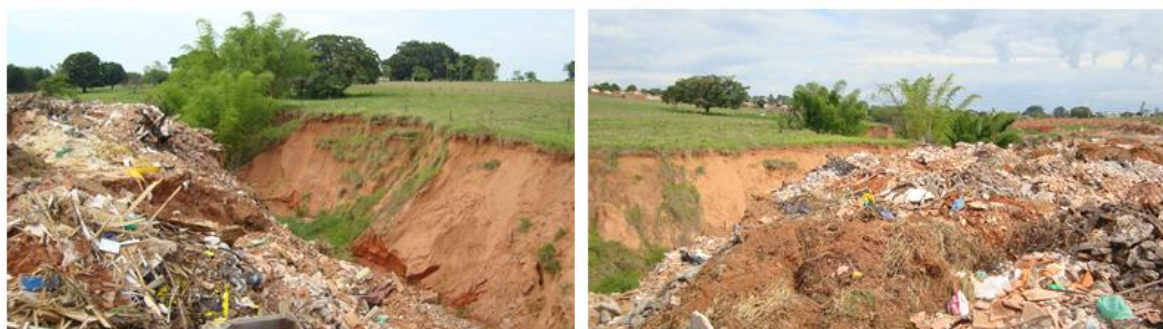
FOTOS 05 e 06 – Aterro de Resíduos da Construção Civil (Licenciado pela CETESB)
