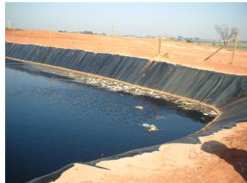
FOTO 02 - Aterro Sanitário – Lagoa impermeabilizada para tratamento de chorume Data: 08.2005
