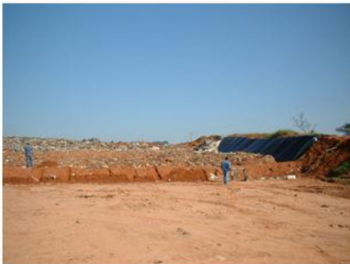
FOTO 01 – Aterro Sanitário – Célula impermeabilizada Data: 08.2005
