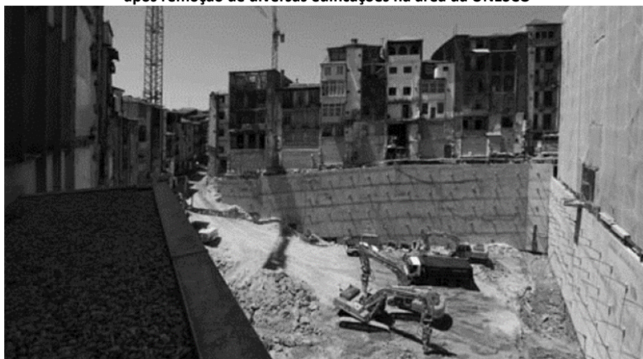
Figura 4: Quadra das Cardosas no Porto – durante a intervenção – construção de subsolo no miolo da quadra, após remoção de diversas edificações na área da UNESCO
