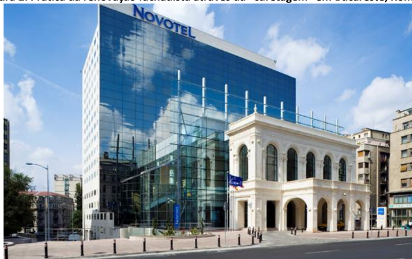
Figura 2: Prática da renovação fachadista através da “curetagem” em Bucareste, Romênia
