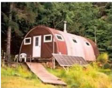
Figura 1: Sistema fotovoltaico autônomo
