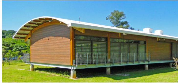
Figura 7: Estrutura metálica de sustentação da sede
