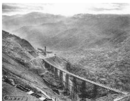
Figura 1 – Viaduto Grota Funda/1867
