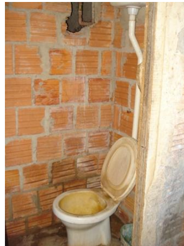
Fig. 06: Vista interna do banheiro (fonte: Adelino A. S. Marinho)
