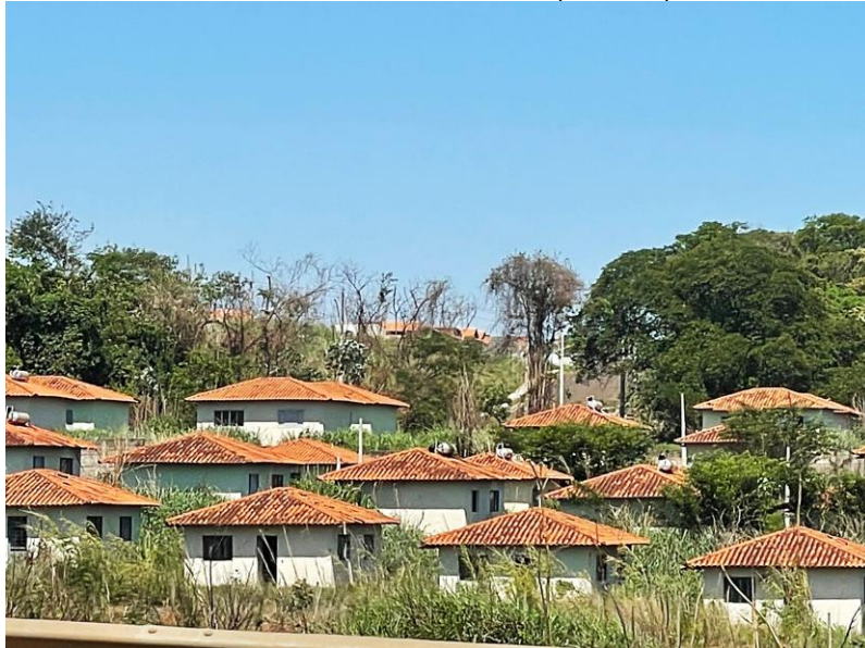
Figura 10 – Uberaba-MG – Loteamento Alfredo Freire IV etapa 1 visto pela rodovia BR-050 (2022)
