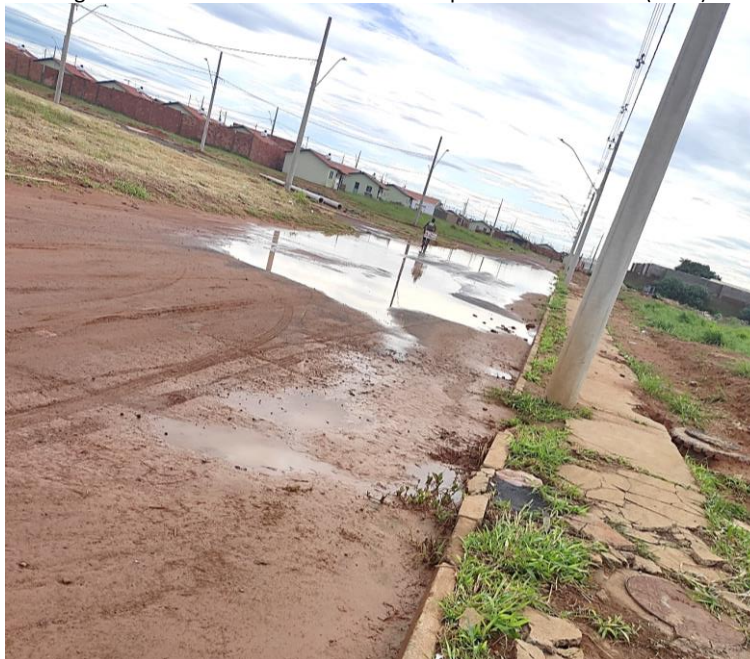
Figura 9 – Uberaba-MG: Avenida do Parque dos Girassóis IV (2023)
