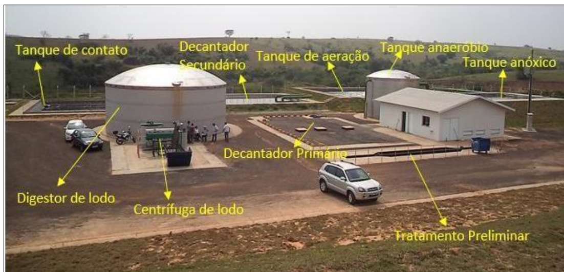
Figura 2 – Equipamentos do tratamento de esgoto doméstico da ETE Norte de Presidente Venceslau – SP.
