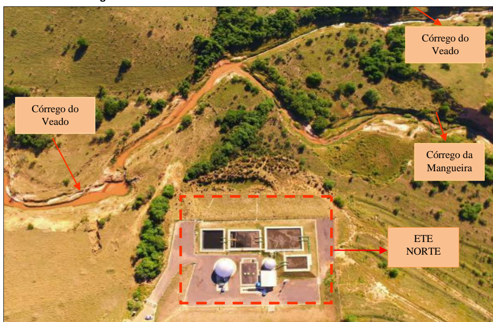
Figura 1 – Vista aérea da ETE Norte de Presidente Venceslau – SP.
