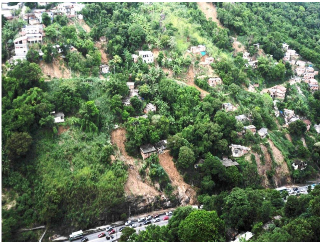
Figura 1 – Uma das encostas na vertente norte da comunidade com várias cicatrizes de deslizamentos ocorridas em abril de 2010.
