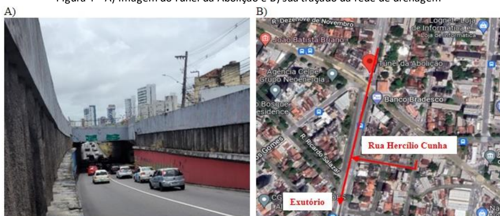
Figura 4 – A) Imagem do Túnel da Abolição e B) sua traçado da rede de drenagem
