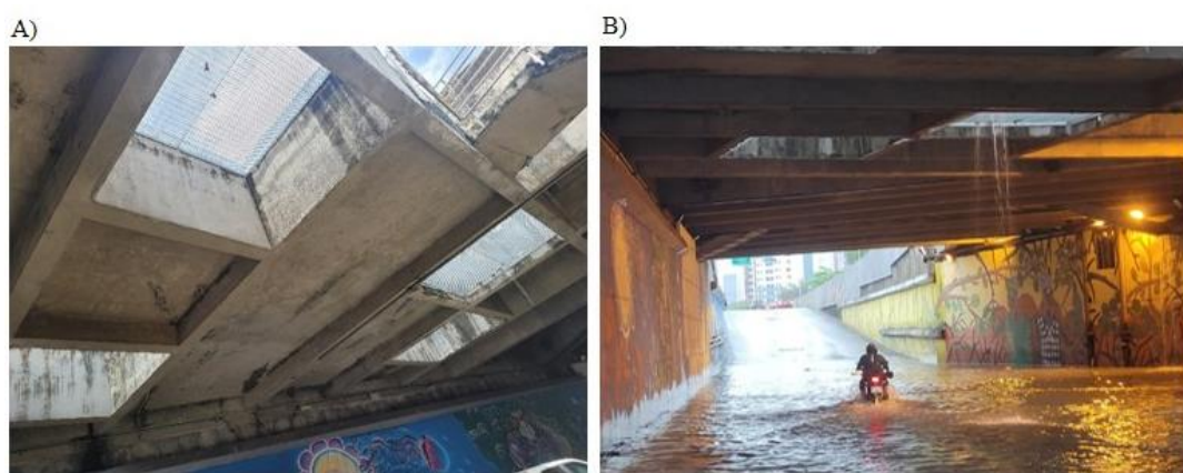
Figura 6 – Detalhe das áreas abertas para ventilação e iluminação (A) e interior do túnel em período de chuva (B).
