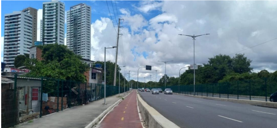
Figure 3 - Via Mangue separating ZEIS Ilha do Destino and Parque dos Manguezais.
