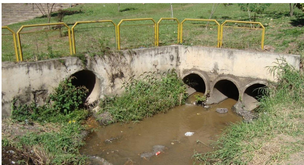
Figura 1. Aspecto geral do lançamento de esgoto no curso d'água que atravessa o Parque do Bicão.
