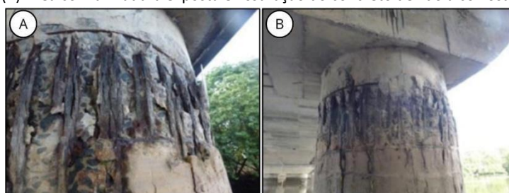
Figura 3 – Corrosão de armaduras. (A) Armadura do tubulão exposta e com perda de seção devido à corrosão; (B) Área com armadura exposta e fissuração do concreto devido à corrosão
