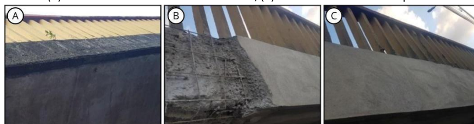
Figura 12 – Processo de recuperação da laje do passeio. (A) Condições da laje do passeio antes da recuperação; (B) Recobrimento do elemento estrutural; (C) Elemento estrutural recuperado
