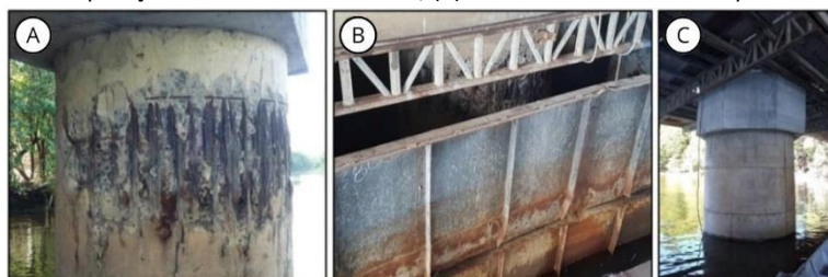
Figura 9 – Processo de recuperação do tubulão. (A) Tubulão da ponte em estado de deterioração; (B) Execução da recuperação dentro de ensecadeira; (C) Elemento estrutural recuperado
