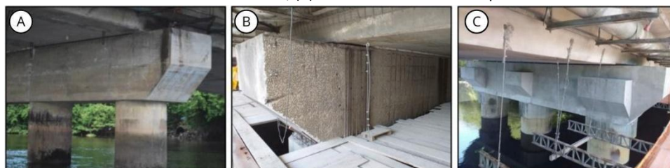
Figura 10 – Processo de recuperação da travessa. (A) Travessa ponte sem manutenção; (B) Execução da recuperação do bloco da travessa; (C) Elemento estrutural recuperado
