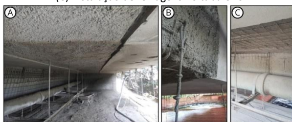
Figura 11 – Processo de recuperação do tabuleiro da ponte. (A) Apicoamento no tabuleiro; (B) Concreto projetado; (C) Instalação de ferragens no tabuleiro
