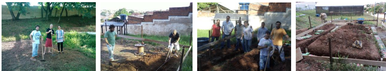
Figura 7. Construção da fundação da Casa Pet.
