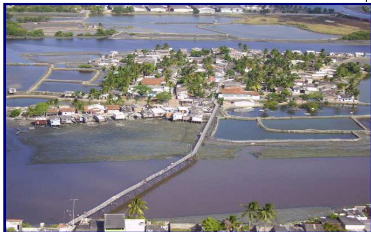
Figura 2 - Vista aérea da Ilha de Deus
