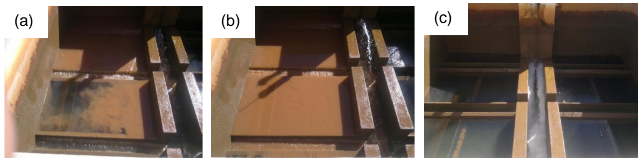
Figura 7 – (a) início da lavagem do filtro, (b) evolução do processo de lavagem e (c) etapa final da lavagem de Filtros da ETA Anápolis.
