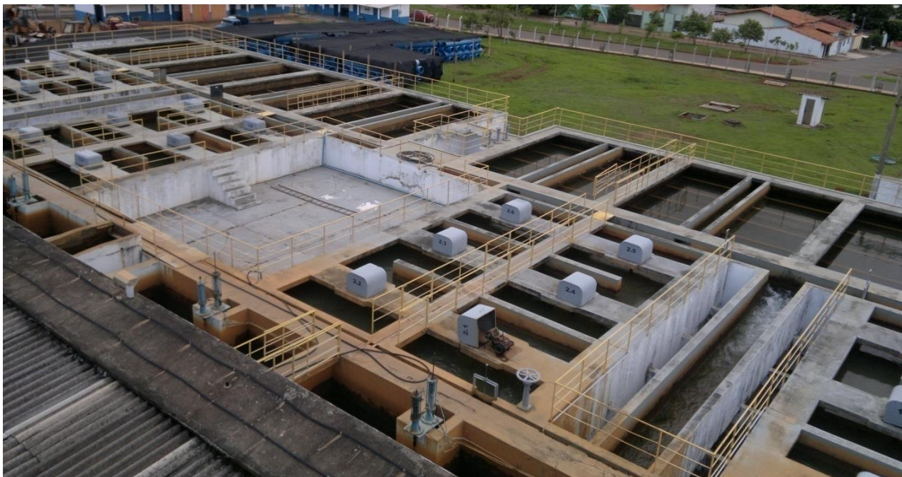
Figura 1 - Estação de Tratamento de Água no bairro Jardim das Américas I Etapa Anápolis/GO.
