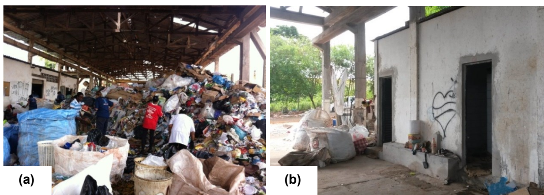
FIGURA 6. (a) Material sendo triado diretamente do local de deposição pelos caminhões; (b) Área Social.
