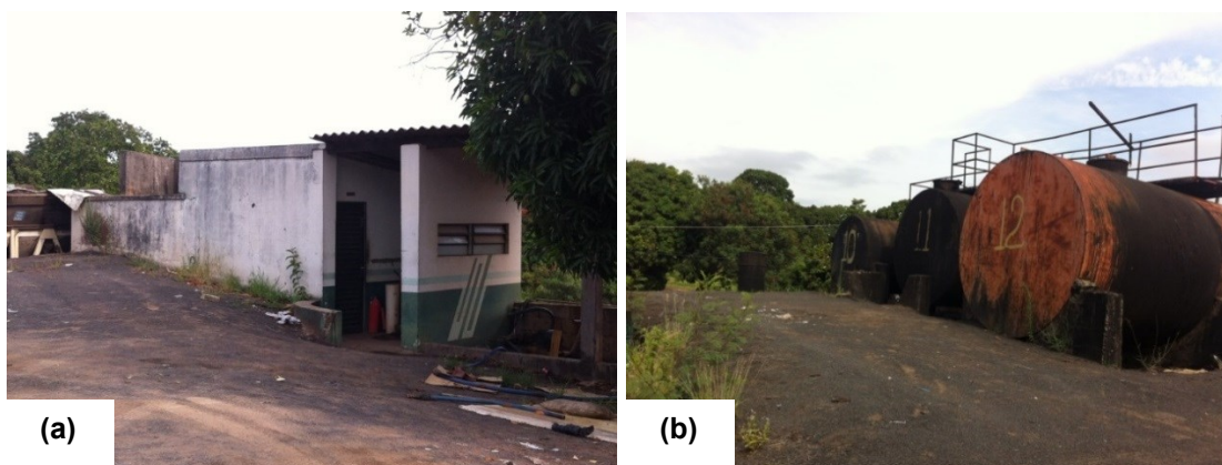
FIGURA 4. (a) Fotografia da antiga fábrica de asfalto; (b) Tanque de armazenamento.
