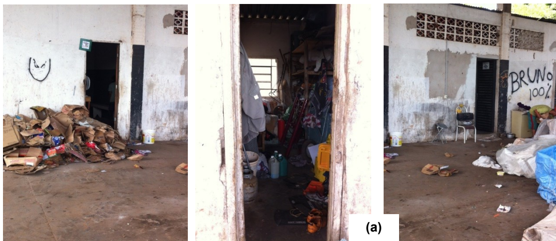
FIGURA 7. (a) Imagem da fachada do refeitório; (b) Imagem da sala utilizada como vestiário masculino; (c) Imagem da fachada do escritório da área social.
