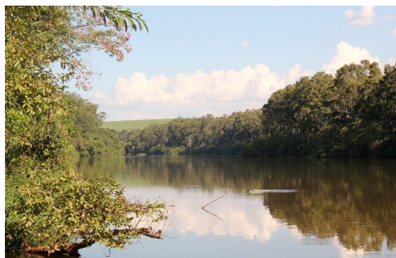
Figura 2. Vista da localização da barragem na bacia hidrográfica do Ribeirão Santo Antônio – São Manuel – SP.
