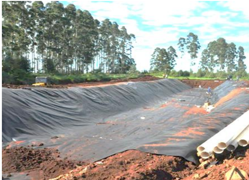
Figura 6: Impermeabilização da base do aterro com geomembrana
