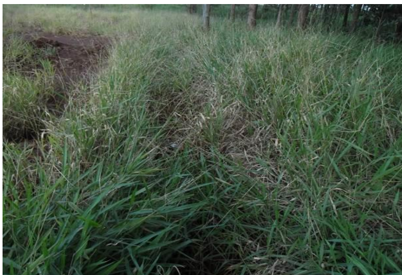
Figura 4: Vegetação no sistema drenagem e acúmulo d'água
