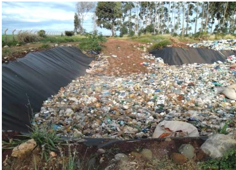
Figura 8: Resíduos sem cobertura e com acúmulo d' água
