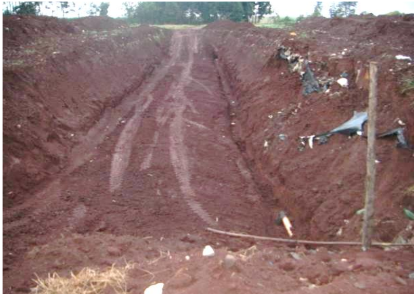
Figura 5: Abertura da vala e instalação de drenagem de lixiviados
