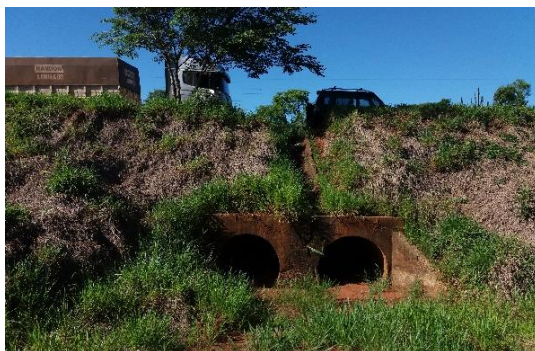
Figura 5: Passagens de fauna com 1,45m de diâmetro sob a SP-613 no interior do PEMD, com formação de bacias de águas pluviais atrativas à fauna.
