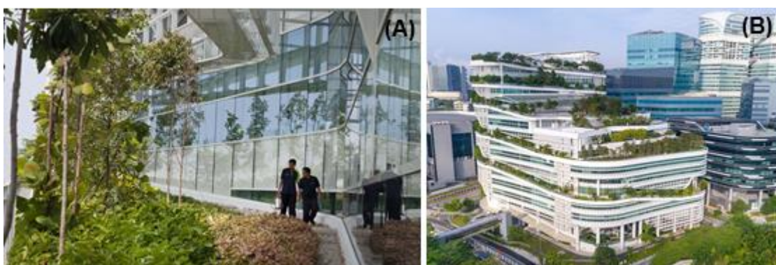
Figura 8 – Rampa ecológica. (A) Funcionamento da rampa ecológica com o espaço destinado à vegetação e a passarela de manutenção. (B) Panorama geral da rampa ecológica que permeia ao longo do prédio.
