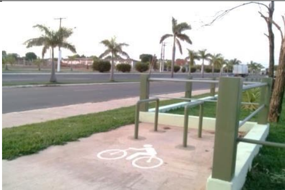
3. C - Bicicletário e mureta de proteção.
