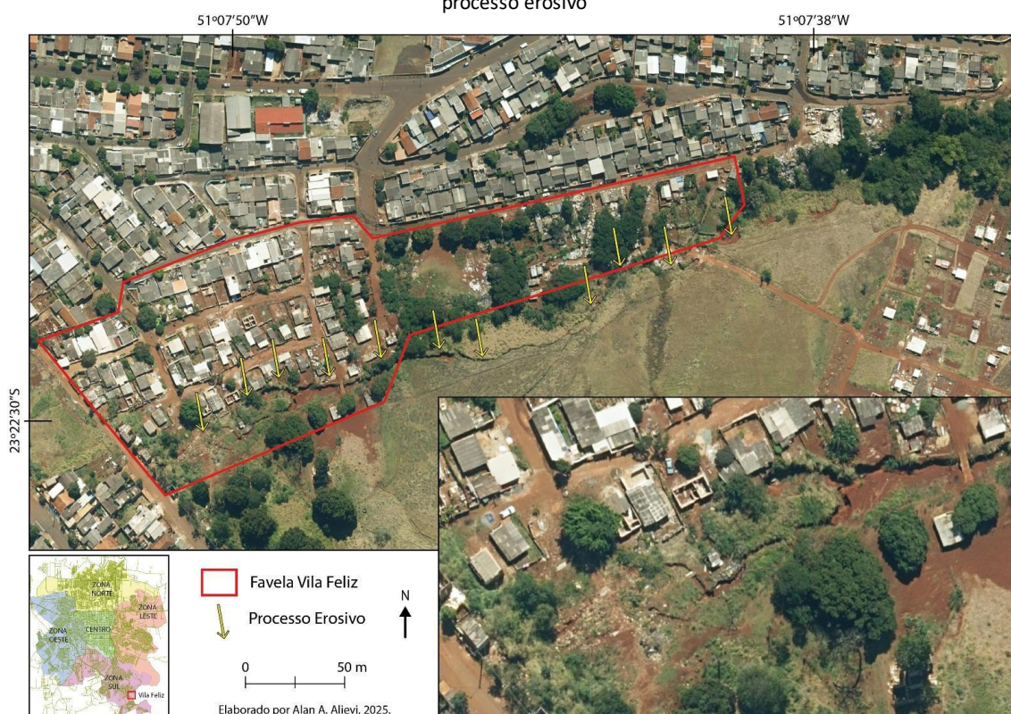
Figura 4 – Localização das residências no território vulnerável Vila Feliz – Londrina- PR com destaque para o processo erosivo
