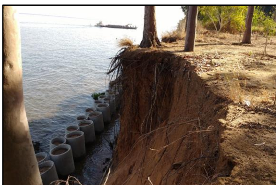
Figura 3 - Processo erosivo instalado na beira do rio Paraná e barreira de contenção
