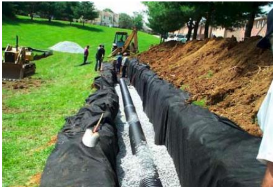
Figura 1: Execução de uma trincheira
