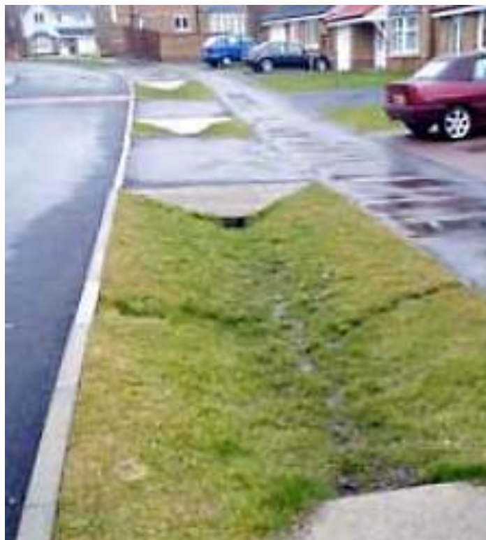
Figura 2: Vala de Infiltração
