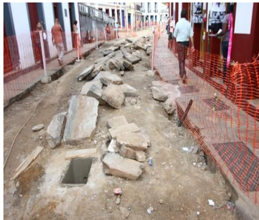
Figura 8: Obras de saneamento básico na rua São José Ouro Preto.
