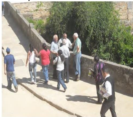
Figura 10: Obras concluídas possibilitando maior fluidez e conforto aos pedestres.
