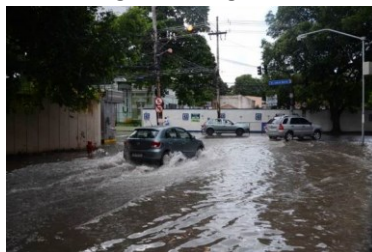
Alagamento provocado pela chuva do dia 05/06/2013.
