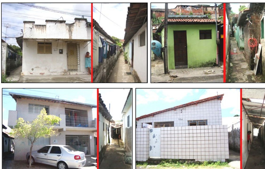
Figuras 03 a 06: Exemplares de HCPAs localizadas em diversas ruas do bairro Varadouro invisibilizadas devido à aparência de habitação unifamiliar das fachadas principais de seus edifícios.
