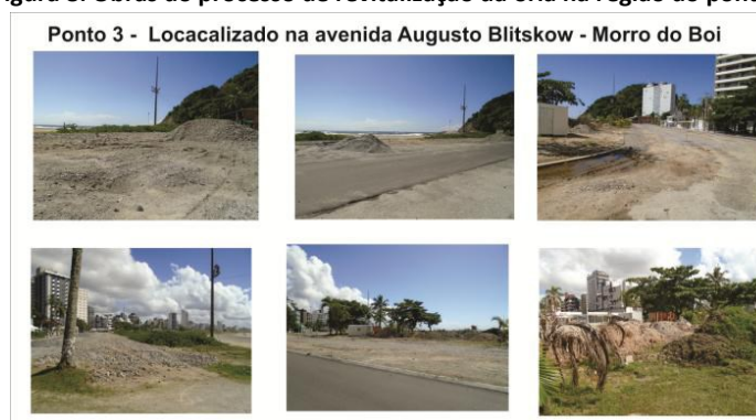
Figura 8: Obras do processo de revitalização da orla na região do ponto 3
