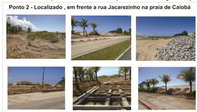
Figura 07: Obras do processo de revitalização da orla na região do ponto 2
