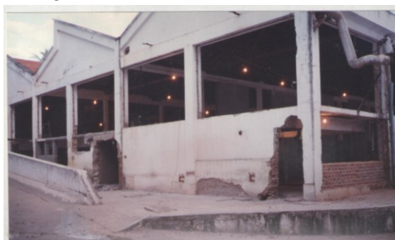
Figura 10 – Prédio de laboratórios- em reforma
