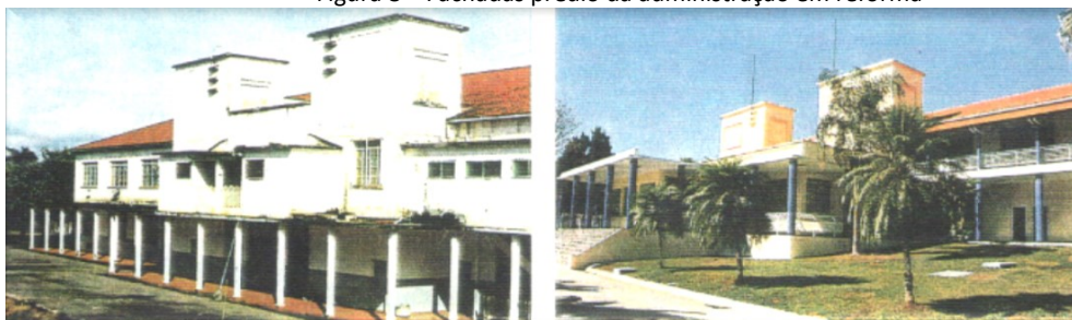
Figura 8 – Fachadas prédio da administração em reforma
