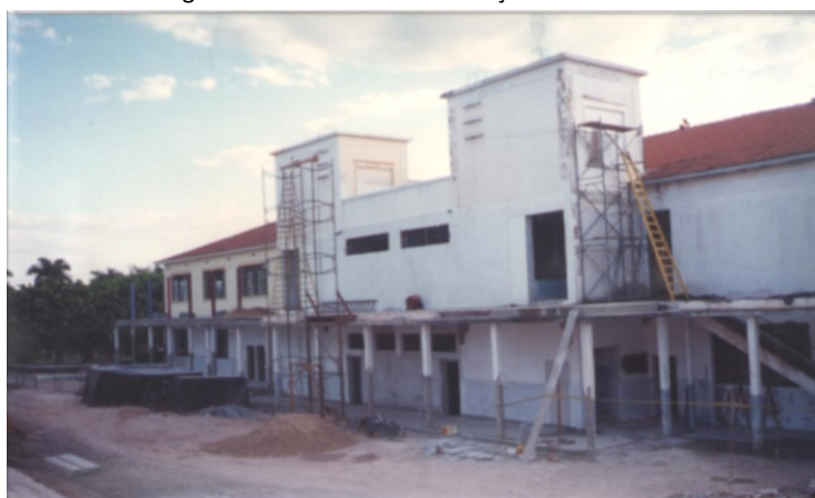
Figura 7 - Prédio da administração em reforma
