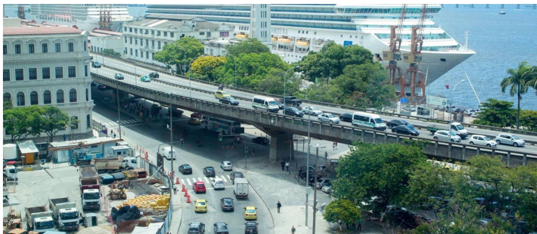
Figura 2: Elevado da Perimetral: degradação através das décadas.
