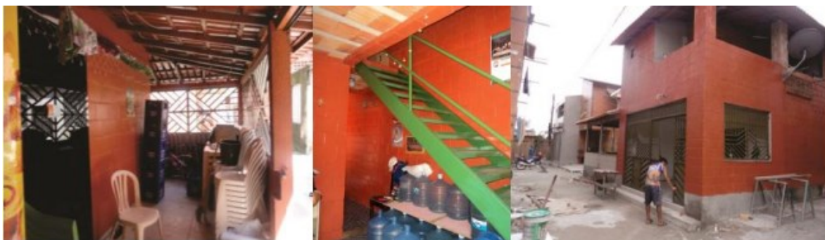
Figura 3: Casas do conjunto Habitacional Vila da Barca com adaptações
