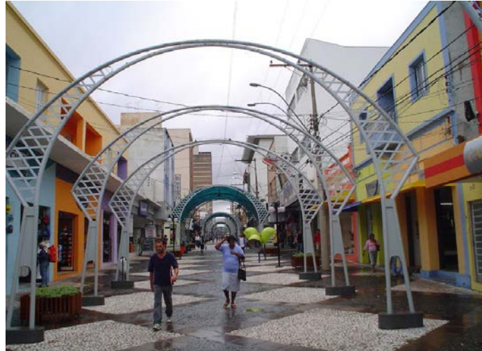
Figura 06 – Arcos e fachadas descaracterizados do Calçadão da Batista de Carvalho.
