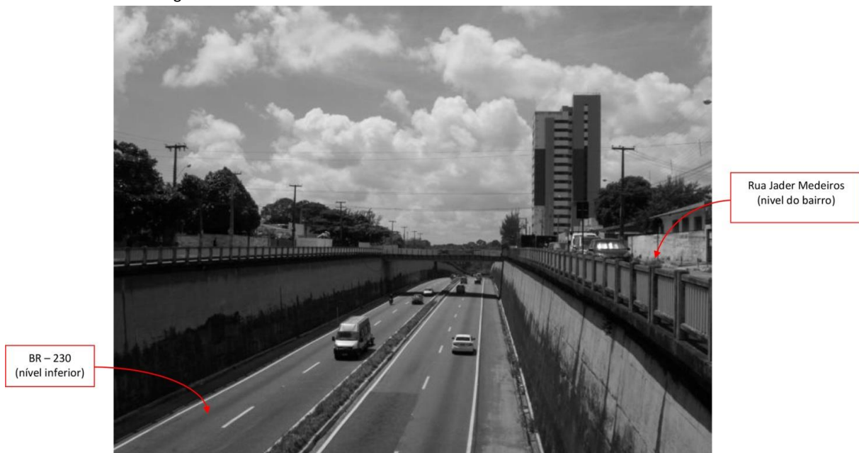
Figura 6 – Problemas nas conexões transversais: BR-230 e Rua Jader Medeiros.
