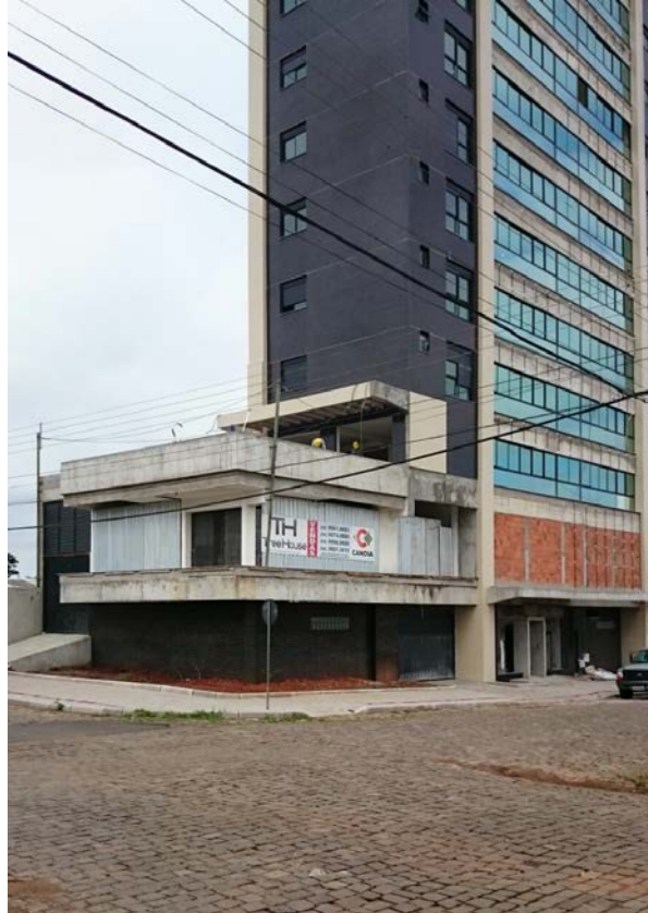
Figura 6 - Prédio localizado no ponto de análise 09
