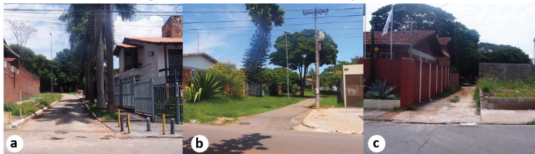
Figuras 13, 14 e 15: Acessos ao interior da quadra F40
