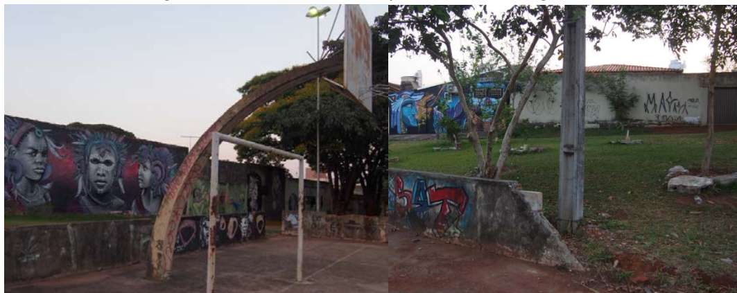
Figuras 5 e 6: Quadra F-40: área esportiva deteriorada e grafites.
