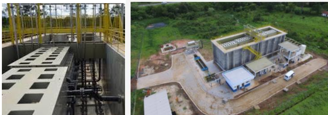
Figuras 5 e 6: ETE Samambaia (processo construtivo)
