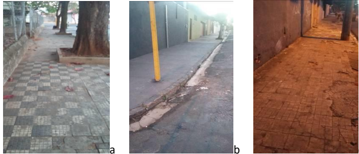
Figura 4: Problemas relacionados ao Tema Acessibilidade - a) Largura efetiva; b) Rampa de acesso; c) Iluminação
