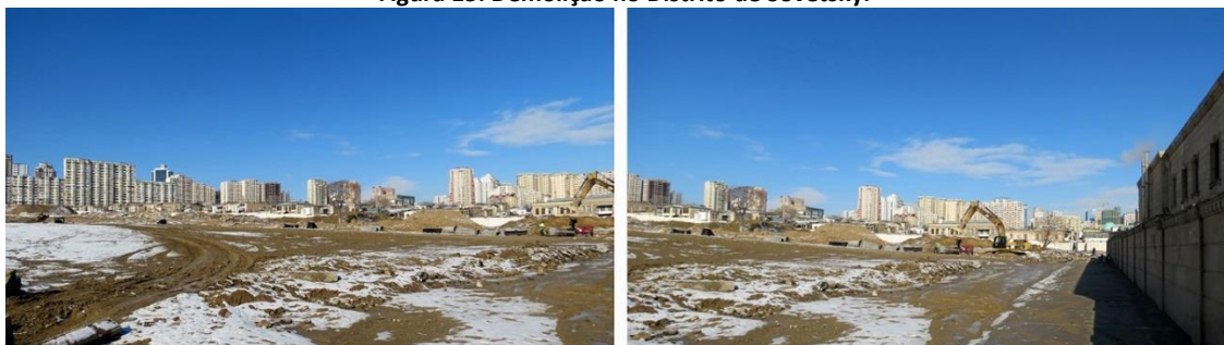
Figura 15: Demolição no Distrito de Sovetsky.
