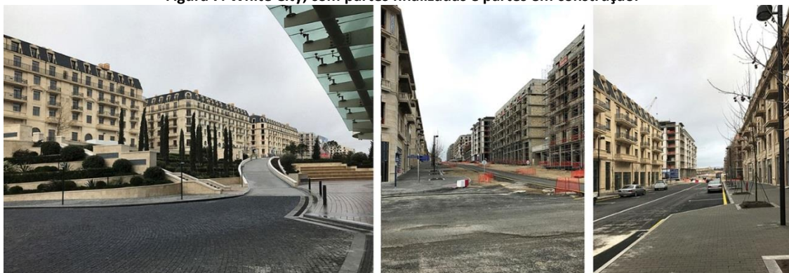
Figura 7. White City, com partes finalizadas e partes em construção.
