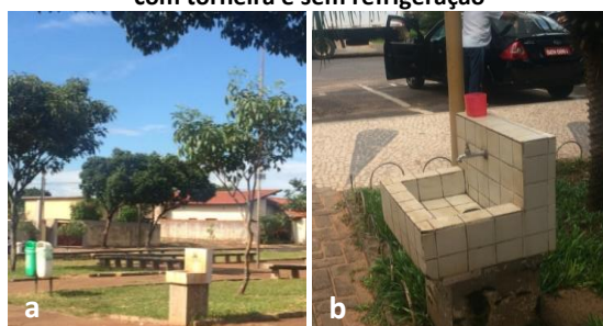
Figura 5: (a) Praças Augusto Piacenti (b) Praça São Judas Tadeu - bebedouros de alvenaria revestido em cerâmica, com torneira e sem refrigeração
