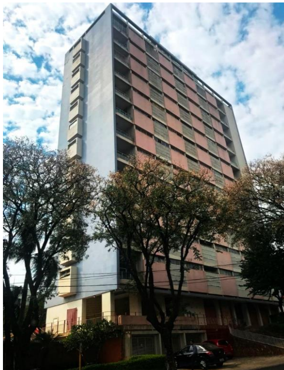
Figura 2 – Estudo de caso: Edifício Brasil Portugal
