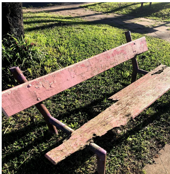
Figura 6: bancos com estrutura danificada e impróprios para o uso
