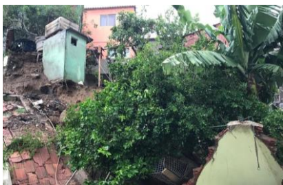
Figura 3: Ocorrência de deslizamentos de solo e queda de muros no bairro Prainha, após chuva intensa.
