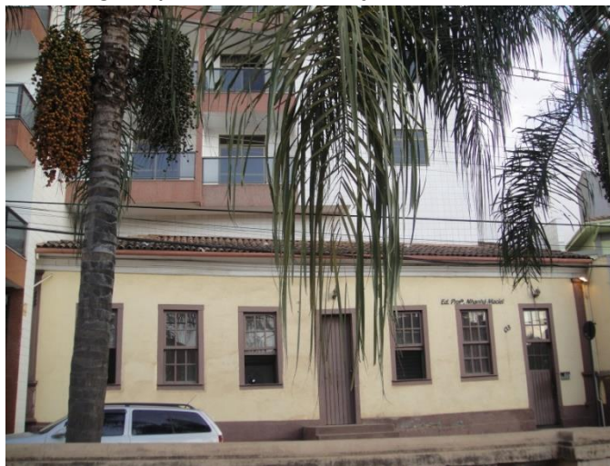
Figura 1 – Fachada tombada do antigo hospital da cidade, na Praça Emílio Jardim, com o edifício aos fundos
