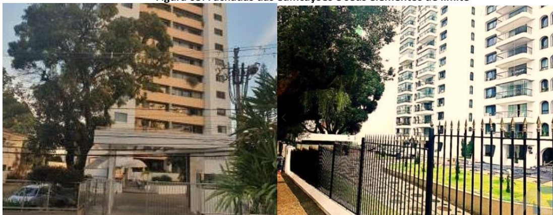
Figura 03: Fachadas das edificações e seus elementos de limite
