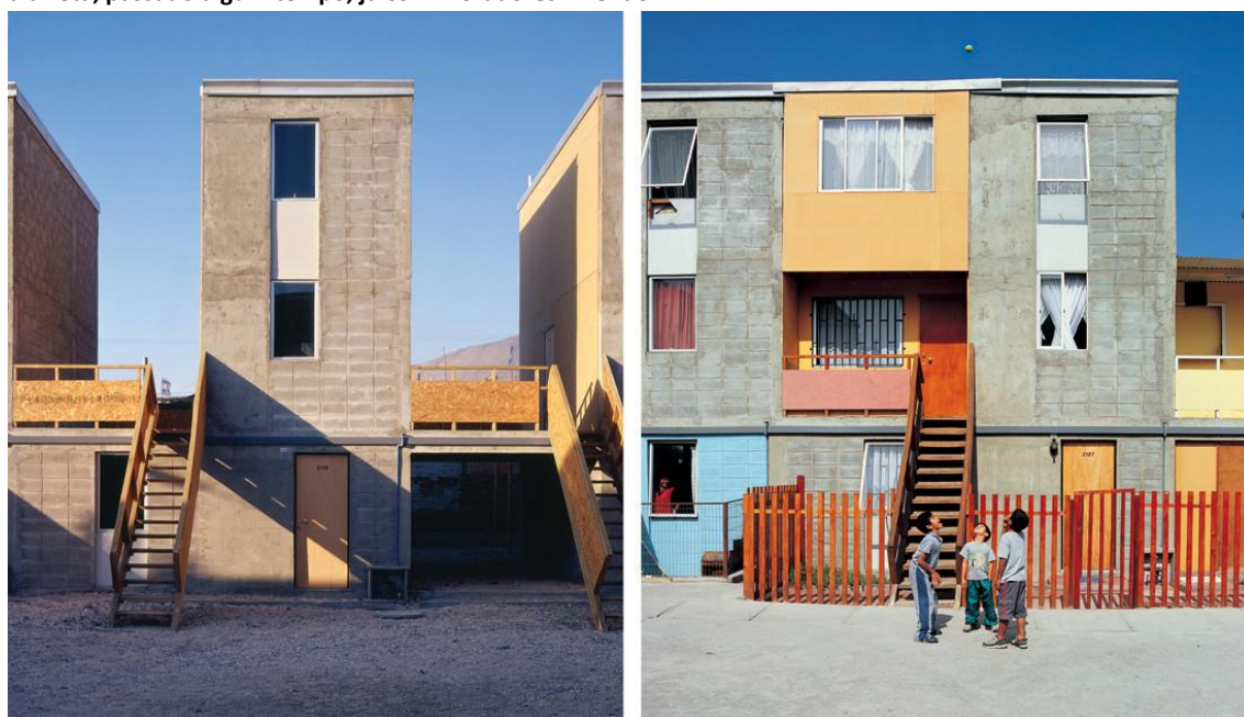
Figura 4: projeto Quinta Monroy se transformando ao longo do tempo. À esquerda, logo que concluídas as obras e à direita, passado algum tempo, já com moradores vivendo.
