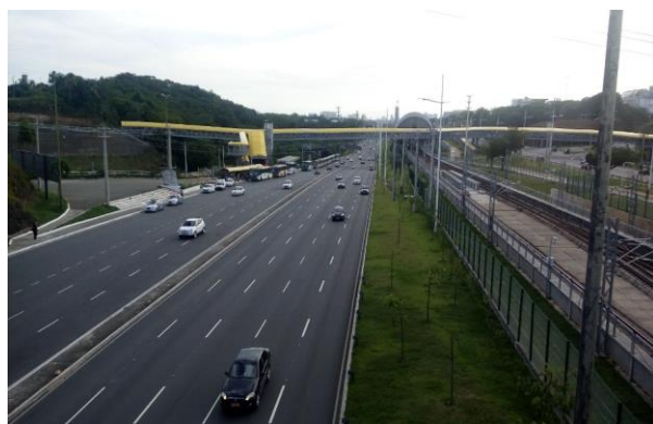
Figura 15: Vista Superior Esquerda à Estação Pituauçu
