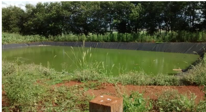
Figura 8 – Lagoa para armazenamento do percolado
